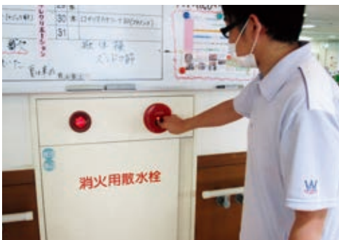
施設では火災報知器の下に格納されています。
